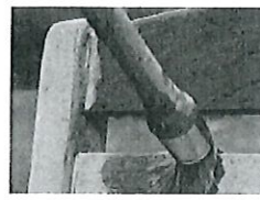
Les travaux de peinture
